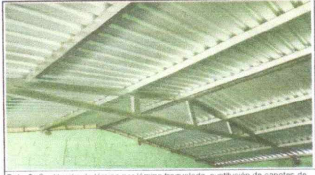
Foto 2: Sustitución de lámina por lámina troquelada, sustitución de capotes de lámina por lámina troquelada, sustitución de elementos de fijación, sustitución de estructura de soporte de madera por metal.
