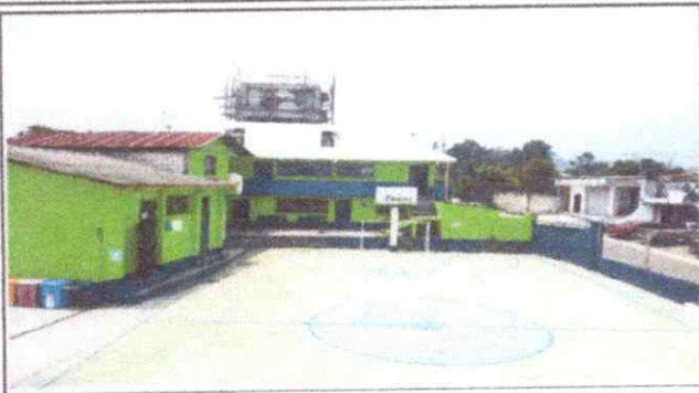
Foto 1: Sustitución de canal de PVC, sustitución de bajada de agua pluvial de metal por tubo PVC y sustitución de soporte o pescante de metal para canal.
