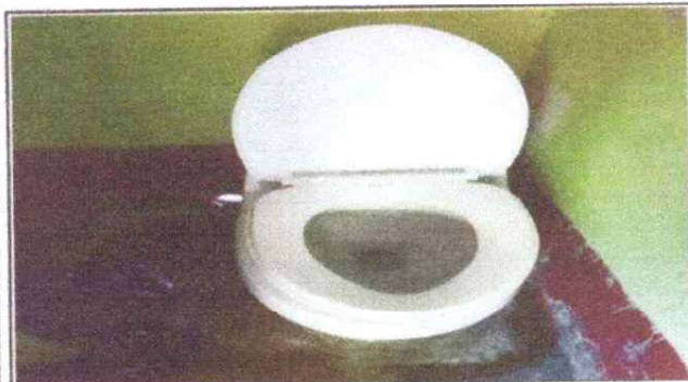
Foto 3: Sustitución de inodoro (6)
